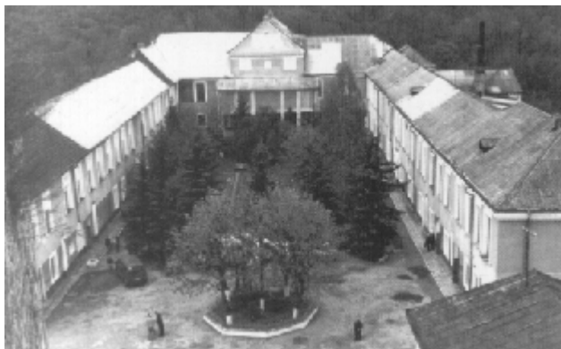
Dawny klasztor ss. Niepokalanek w Jazłowcu, stan obecny przed remontem
