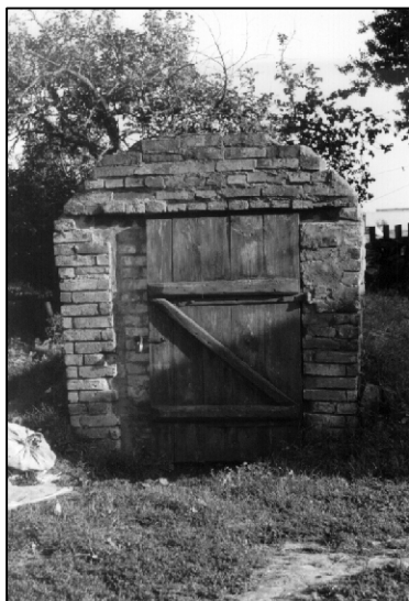
Obecny stan piwnicy Totocia
